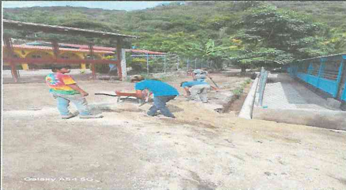
En proceso de reparacion de muro perimetral.
