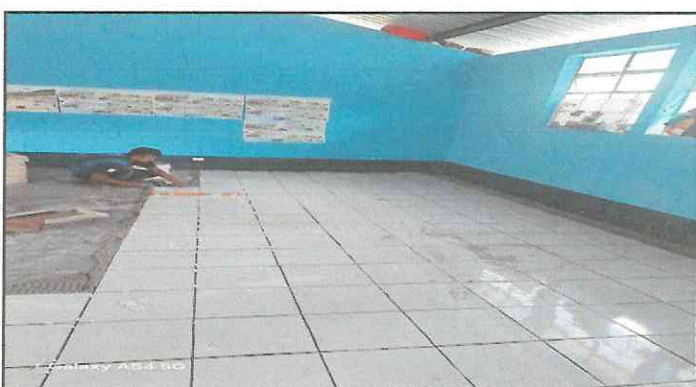
En proceso de sustitucion de piso en aulas.
