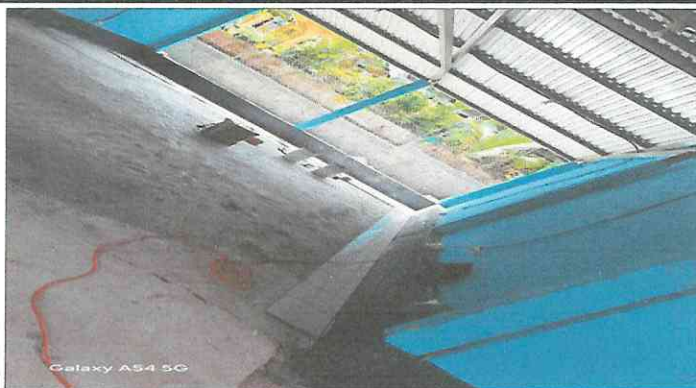
En proceso de sustitucion de piso en salon de uso multiples.
